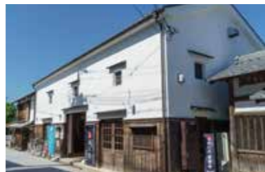
遠久邑八幡堀 p.70 OKUMURA Hachimanbori
